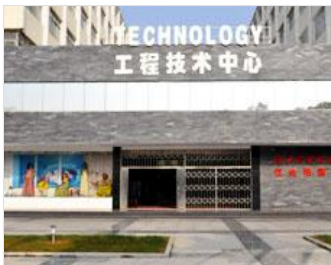
工程技术中心
